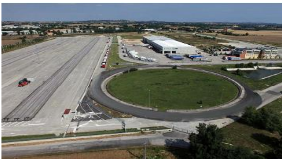
Fig.10 – Sito POW03: Marche, Interporto di Jesi
